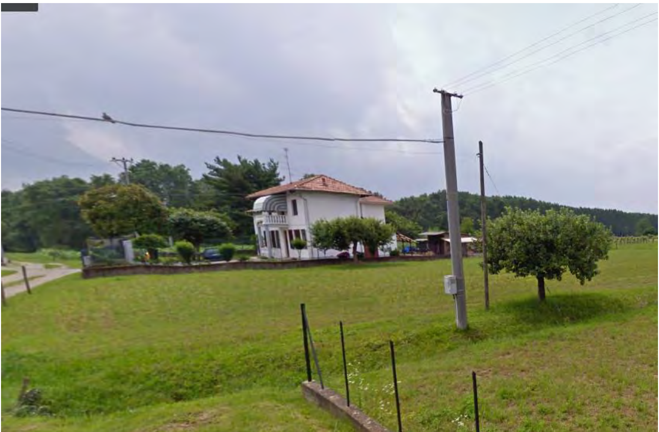
Lotto n° 6 - Vista est dalla strada
